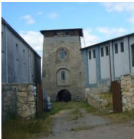
Fotografia 1 Wieża wyciągowa do transportu wsadu wielkopieczowego z 1798 r. w Porębie Źródło: zdjęcie własne wykonane na potrzeby inwentaryzacji
