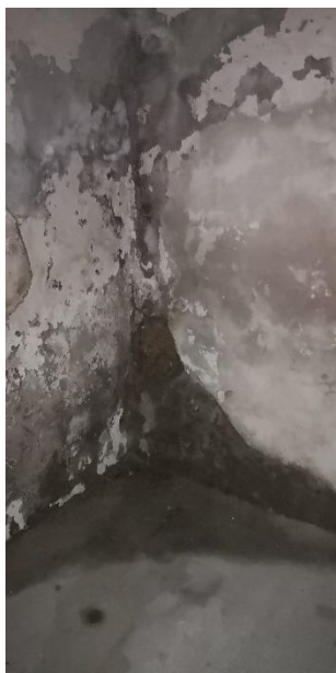
Zdjęcie: zawilgocenia pomieszczenia byłego schronu OPL
