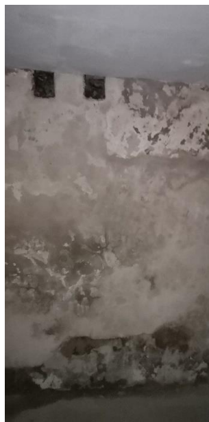
Zdjęcie: zawilgocenia ściany południowej w obrębie byłego schronu OPL
