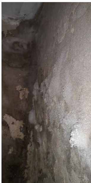
Zdjęcie: wykwyty solne w obrębie pomieszczenia byłego schronu OPL
