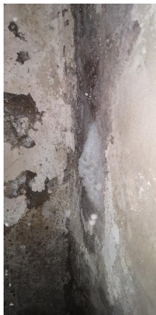
Zdjęcie: wykwyty solne i zagrzybienie w obrębie pomieszczenia byłego schronu OPL
