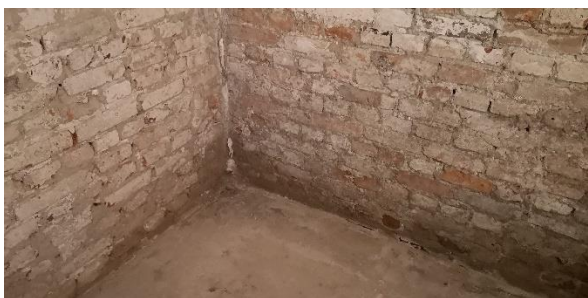
Zdjęcie: zawilgocenia na styku ściany i posadzki w pomieszczeniu planowanym na grotę solną
