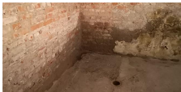
Zdjęcie: zawilgocenia na styku ściany i posadzki w rogu budynku w pomieszczeniu planowanym na grotę solną
