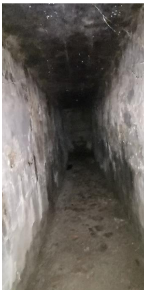
Zdjęcie: tunel prowadzący do zewnątrz schronu OPL. Widoczne zagrzybenie pomieszczenia.
