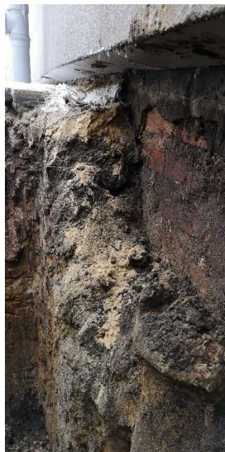
Zdjęcie: Odkrywka - widoczne ubytki hydroizolacji,
