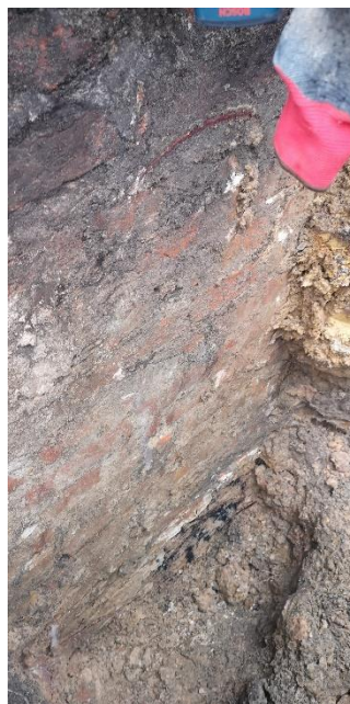
Zdjęcie: Odkrywka fundamentu. Widoczne resztki hydroizolacji bitumicznej.
