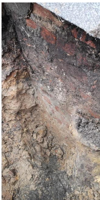
Zdjęcie: Odkrywka fundamentu. Widoczna stara rura kanalizacyjna
