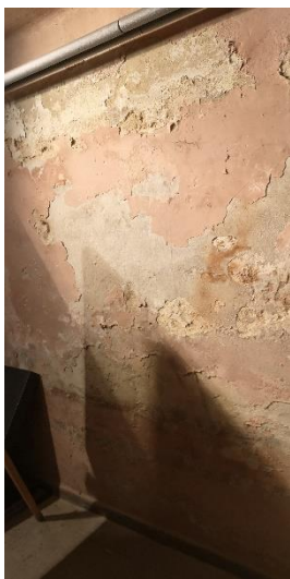
Zdjęcie: Zawilgocenia i ubytki tynku ściany części niepodpiwniczonej w obrębie korytarza
