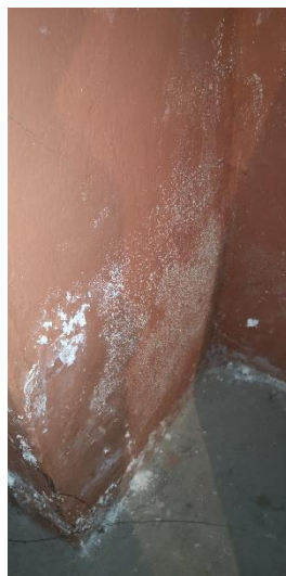
Zdjęcie: Zawilgocenia, zmurszałe tynki, pleśń i grzyb w obrębie pomieszczenia związku górbiarskiego
