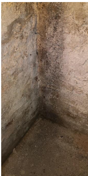
Zdjęcie: Widoczne zagrzybienie w pomieszczeniu planowanym na grootę solną
