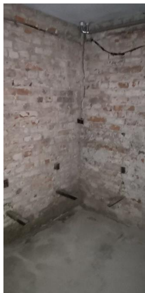
Zdjęcie: Widoczne podciąganie wilgoci w ścianach w pomieszczeniu planowanym na grootę solną
