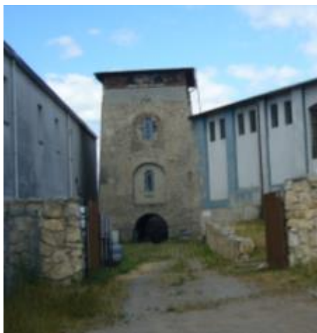
Fotografia 1 Wieża wyciągowa do transportu wsadu wielkopieczowego z 1798 r. w Porębie Źródło: zdjęcie własne wykonane na potrzeby inwentaryzacji
