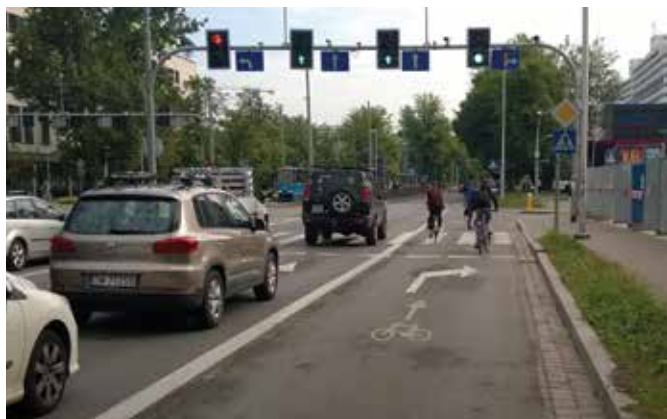
Zdjęcie 48 Prowadzenie ruchu rowerowego „na wprost” z pasa do skrętu w prawo. Wrocław, Polska
