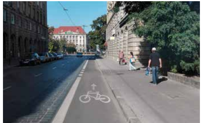
Zdjęcie 24 Asfaltowy kontrapas rowerowy na jezdni z kostki kamiennej. Wrocław, Polska
