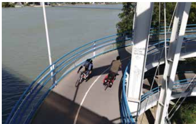
Zdjęcie 62 Pochylnia łącząca drogę dla rowerów z terenem skracającą w lewo w dół
