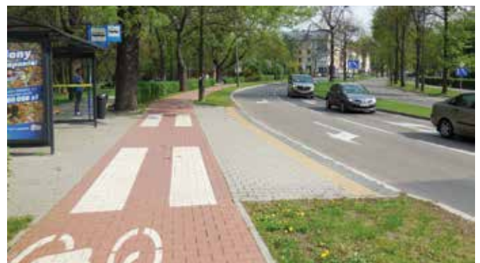
Zdjęcie 21 Tychy, Polska (uwaga - niewłaściwa nawierzchnia drogi dla rowerów)
