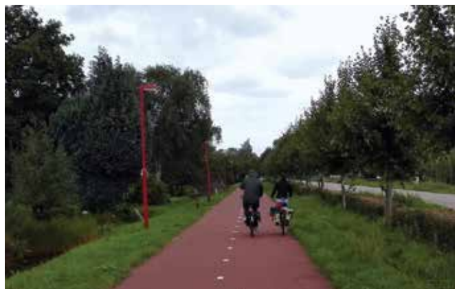
Zdjęcie 66 Oświetlenie drogi dla rowerów. Utrecht, Holandia
