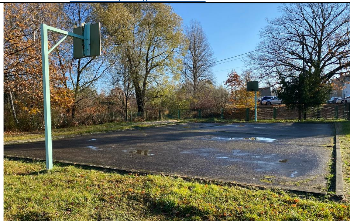
Zdj.1 Istniejące boisko o nawierzchni asfaltowej. [materiały własne]
