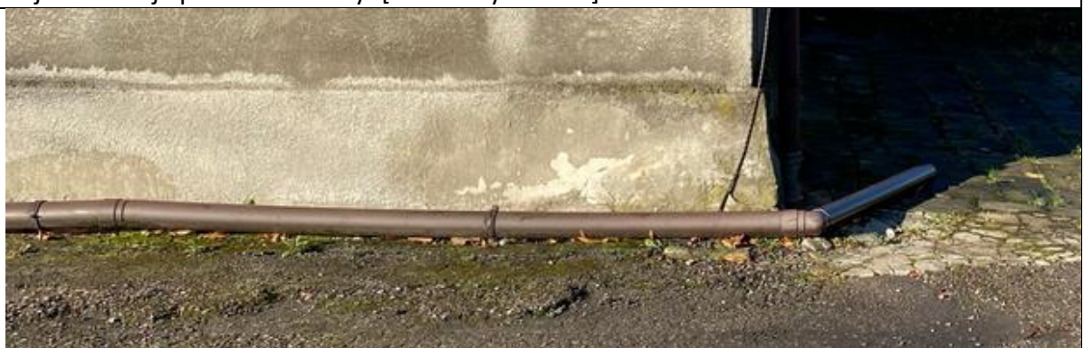
Zdj.7 Istniejąca kanalizacja deszczowa odprowadzająca wodę opadową z dachu szkoły. [materiały własne]
