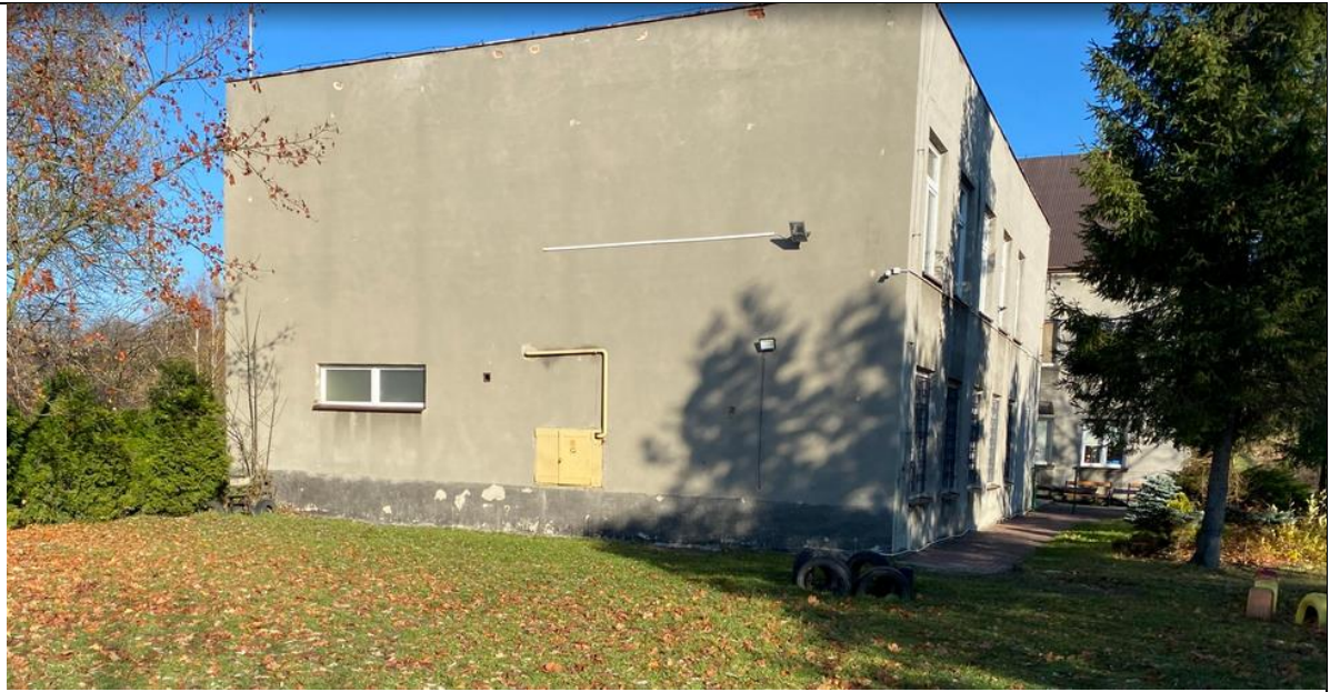
Zdj.5 Elewacja południowa szkoły. [materiały własne]
