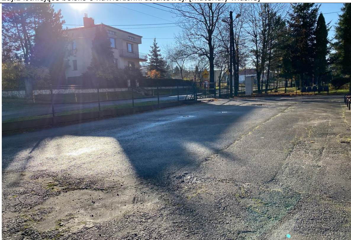
Zdj.2 Istniejąca nawierzchnia utwardzona w strefie wejściowej szkoły. [materiały własne]
